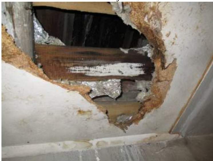
Mycelium koniofory sklepní v místě zatékání u schodiště (mv7)
