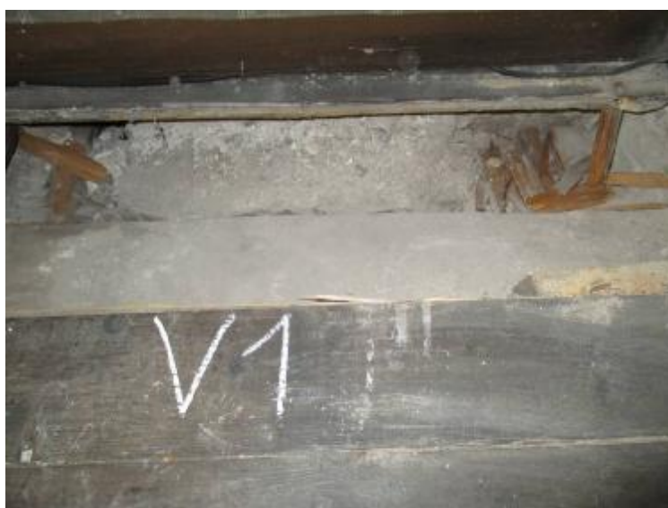
Sonda VI, zhlaví trámů poškozená dřevomorkou domácí
