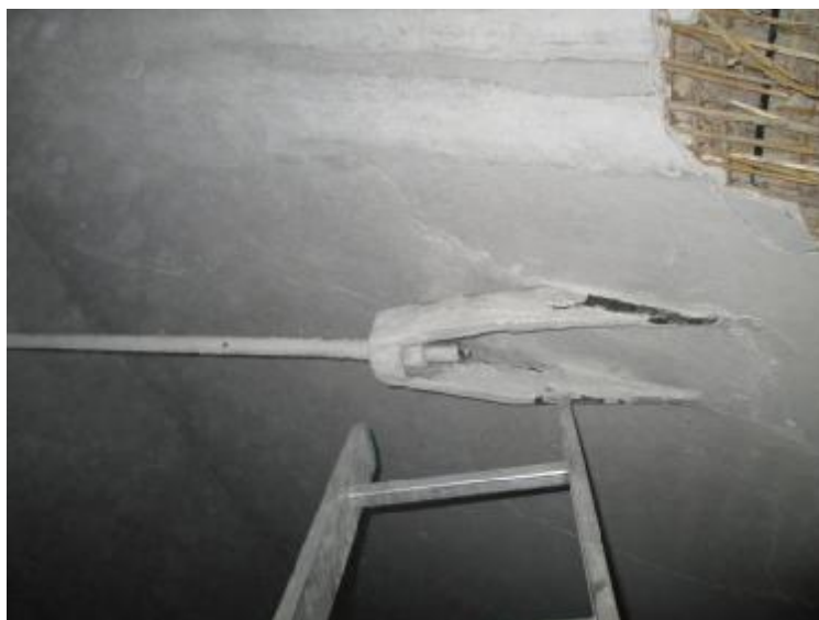
Nepřístupný krov s železnými táhly
