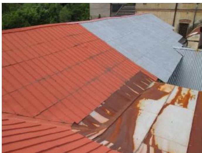
Stav částečně opravené střešní krytiny
