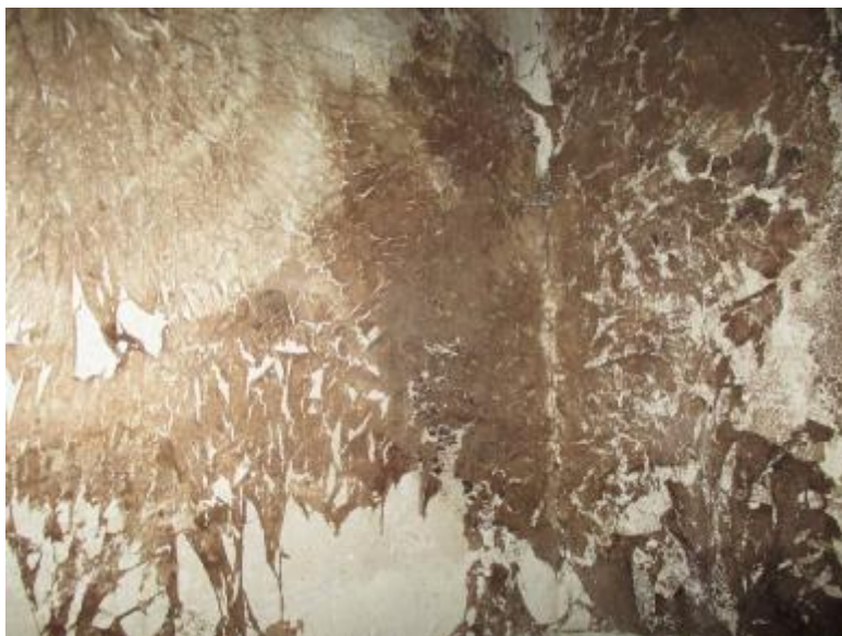
Mycelium dřevomorky domácí na povrchu omítky v průřezu
